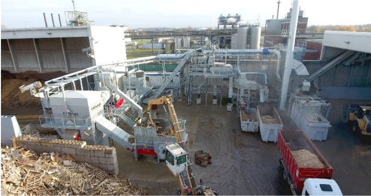
HAAS Altholz-Aufbereitungsanlage in Köln-Niehl
